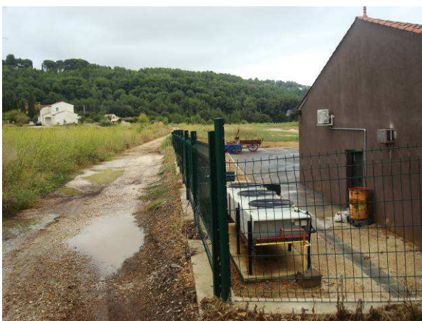
Limite aval de la zone d'étude (Bâtiments de l'école de la Dédrière en aval)
