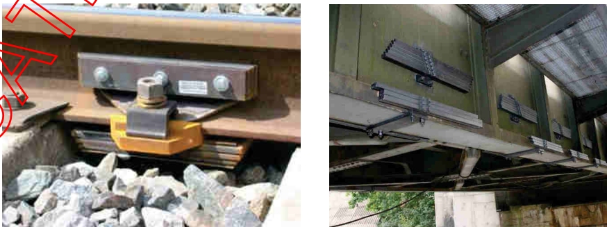
Figures 3 : Absorbeur sur rail & absorbeur sur platelage
