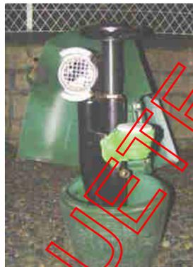
Intérieur d'une borne de puisage avec ½ raccord de 65 mm et compteur d'eau
