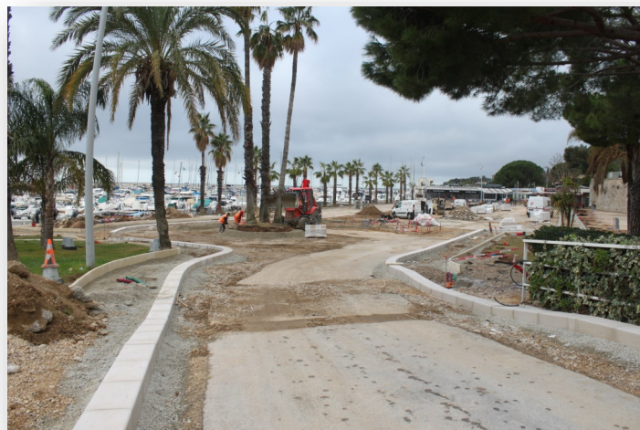
Avancement des travaux sur le terre plein du Vieux Port .
