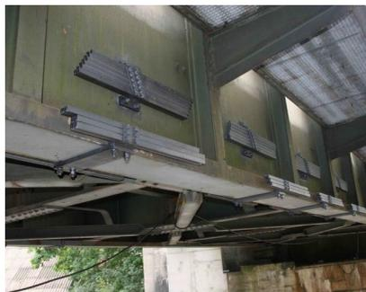
Figures 3 : Absorbeur sur rail & absorbeur sur platelage
